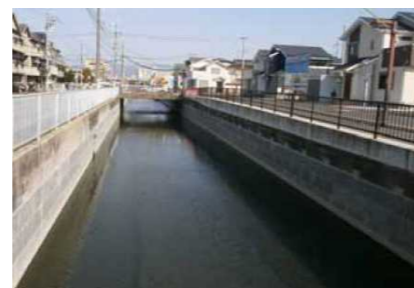
農業用排水路整備
