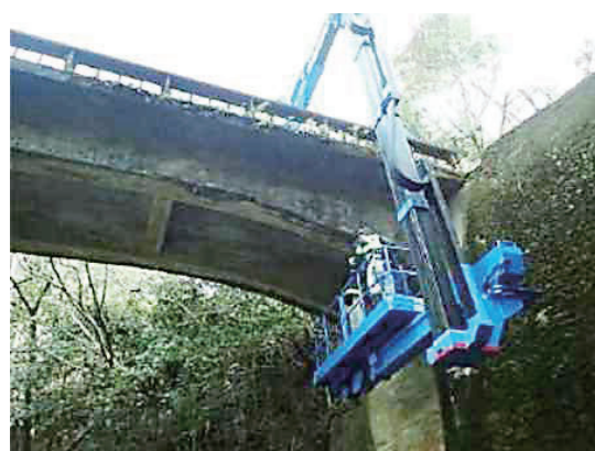
林道橋梁点検
