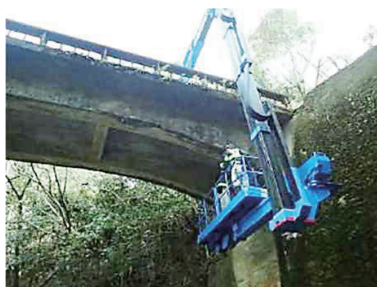
林道橋梁点検
