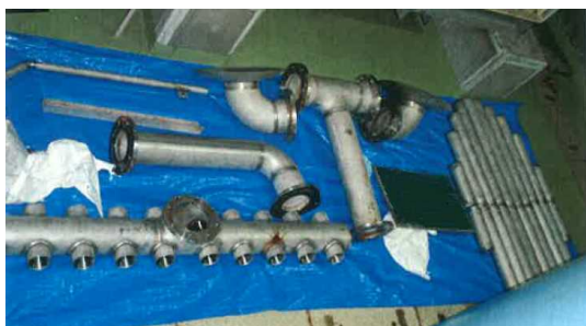
内部配管（撤去中）
