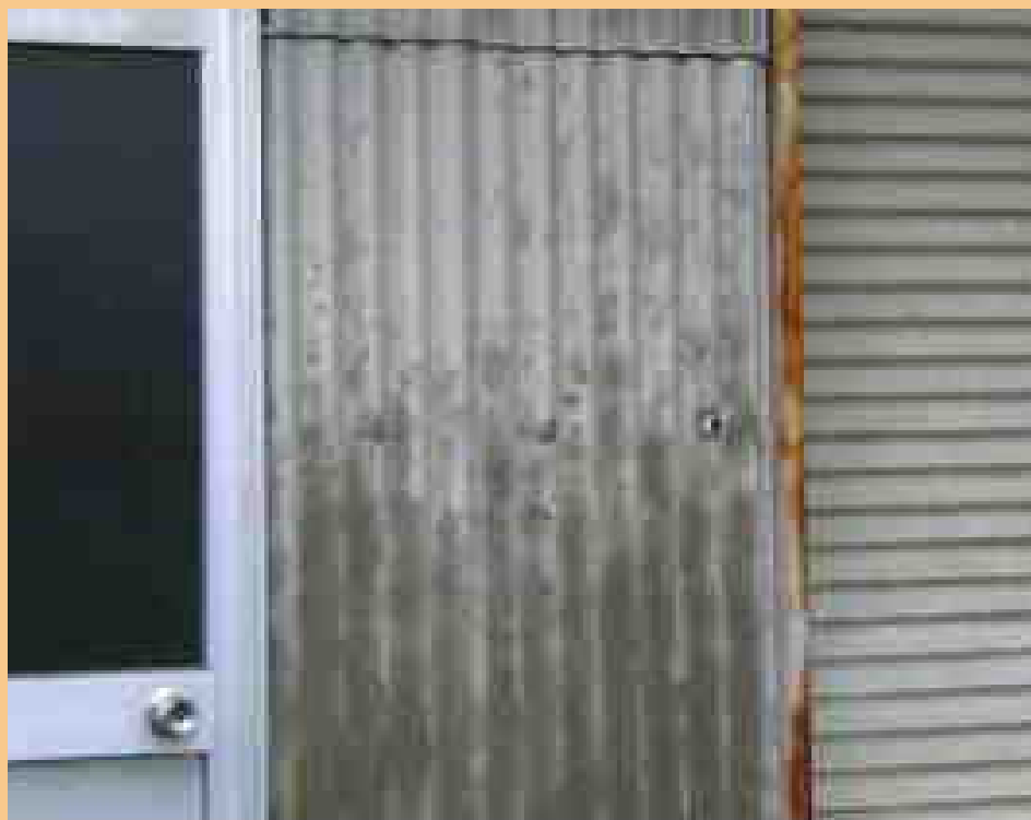
石綿スレート（屋根・外壁）
