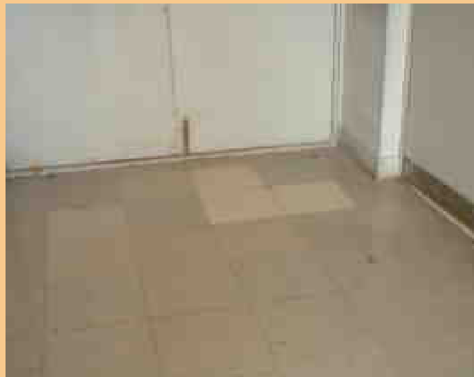
石綿含有ビニール床タイル（床）
