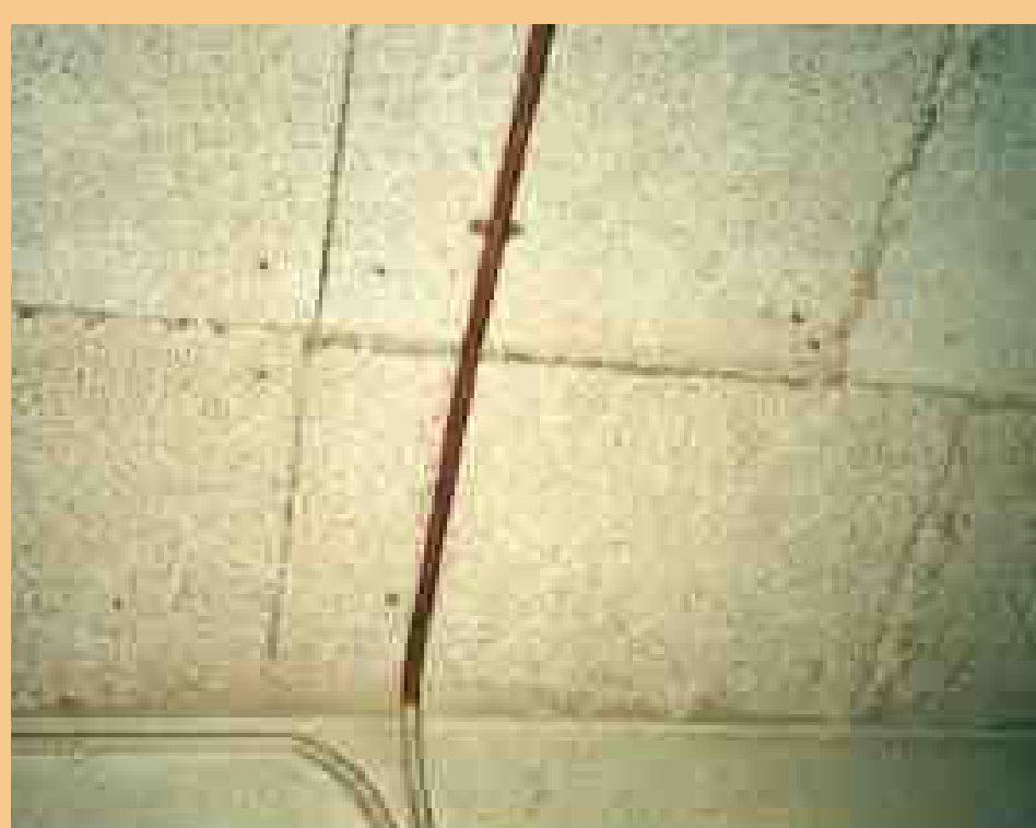
木毛セメント板（打ち込み）
