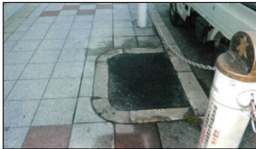
植樹柵の舗装
