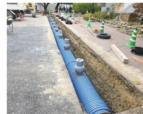
マンホールトイレの整備工事
