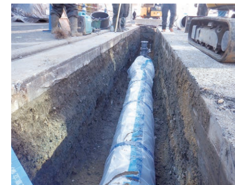
水道管耐震化工事
