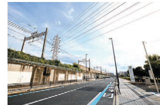
阪急電車の高架に沿ってのんびり。 右側には安満遺跡公園も
