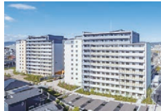
PFI手法で完成した市営富寿栄住宅
