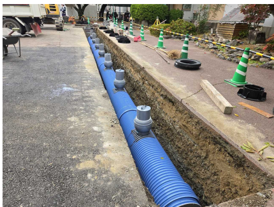
マンホールトイレ（貯留管）の施工
