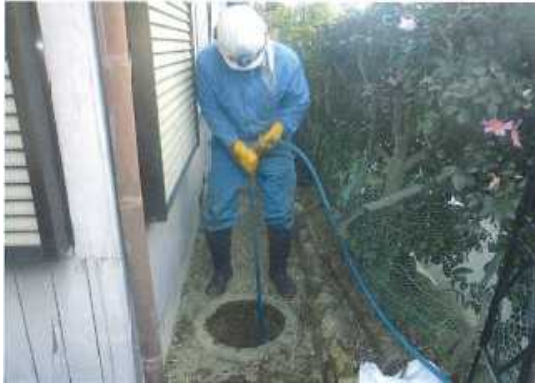
緊急浚渫による下水道の閉塞解消
