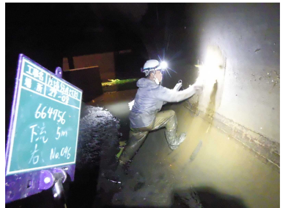
打撃によるコンクリート強度調査
