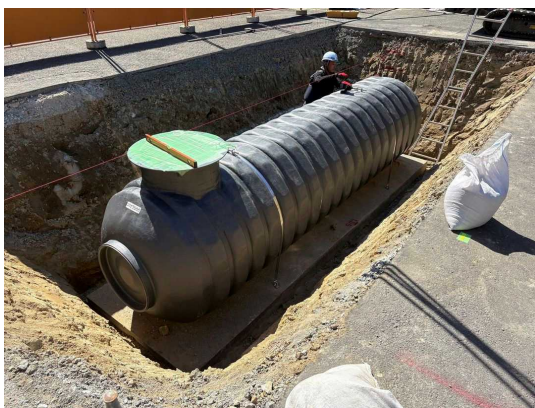
マンホールトイレ（地下貯水槽）の施工
