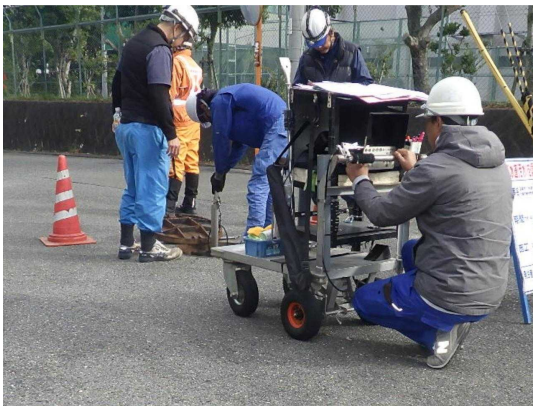
管きょの点検調査
