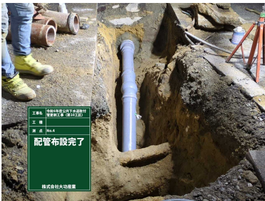
取付管の更新（布設替え）
