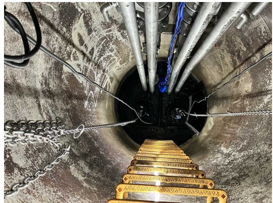
マンホールポンプの更新
