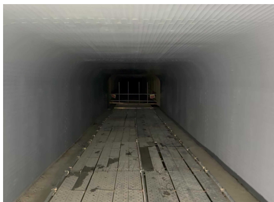
管更生工事の完成
