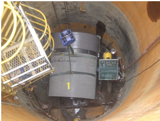
雨水取口の整備
