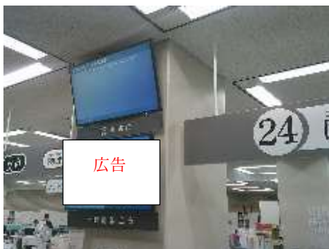
①モニター(新設) 1台
