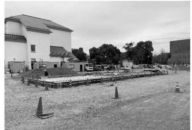
バリアフリースイレ 施工状況
