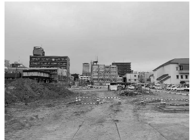
バリアフリー通路 施工状況
