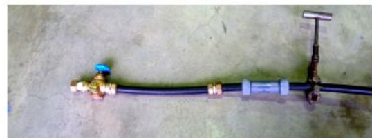
② 圧着後、既設止水栓を撤去し、伸縮ソケットを準備する。
