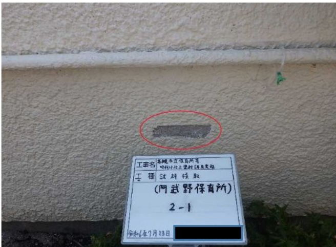
試料No.2 (採取後) 外壁 仕上塗材②
