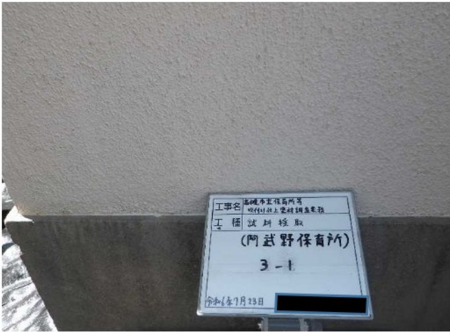
試料No.3 (採取前) 外壁 仕上塗材③
