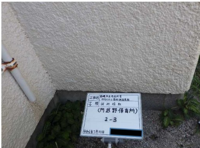
試料No.2 (採取前) 外壁 仕上塗材②
