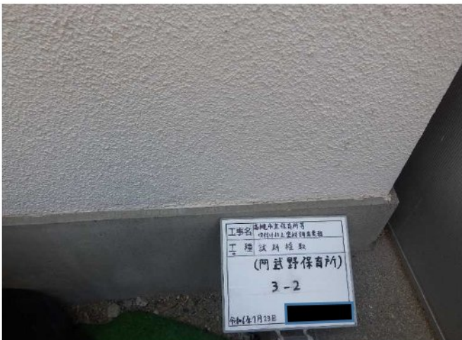
試料No.3 (採取前) 外壁 仕上塗材③
