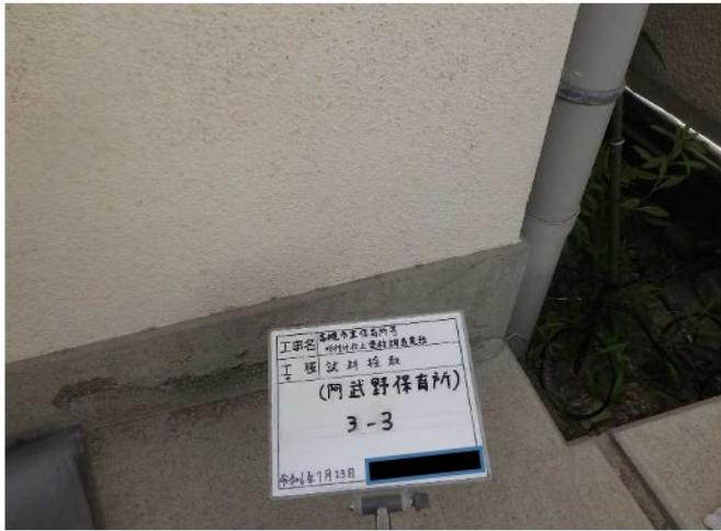
試料No.3 (採取前) 外壁 仕上塗材③
