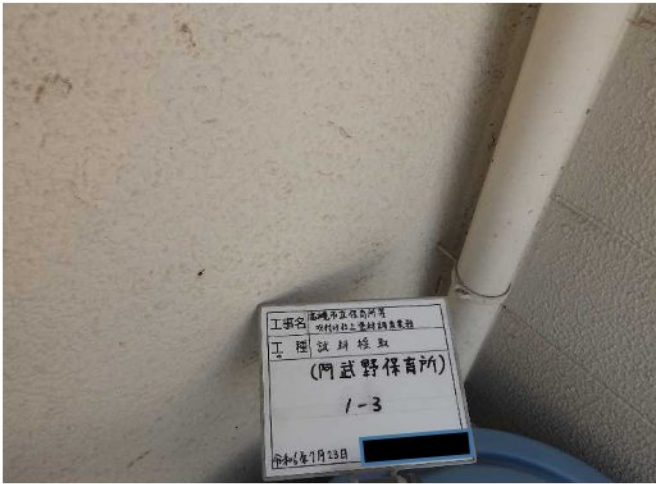
試料No.1 (採取前) 外壁 仕上塗材①
