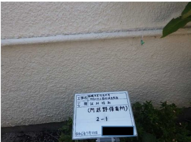
試料No.2 (採取前) 外壁 仕上塗材②
