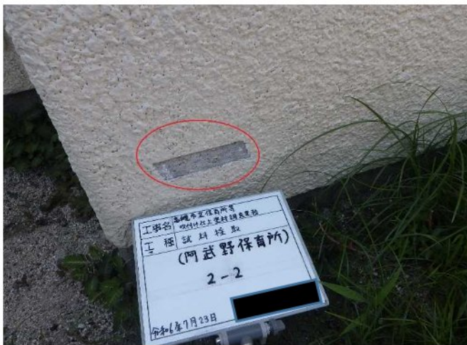
試料No.2 (採取後) 外壁 仕上塗材②
