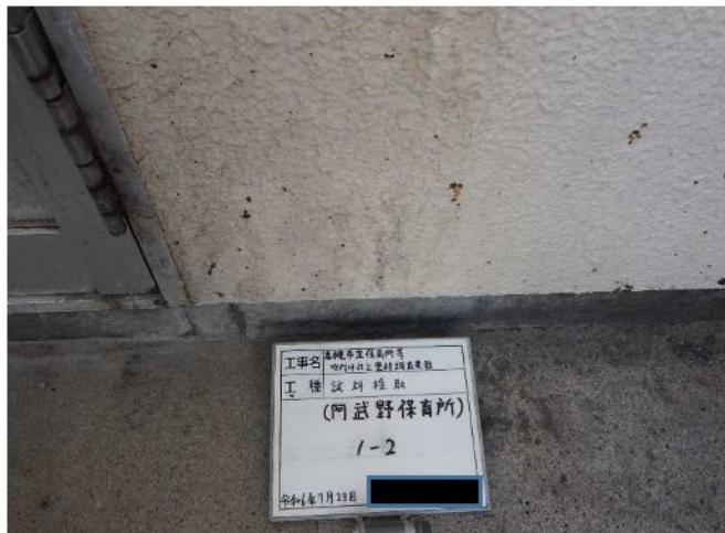
試料No.1 (採取前) 外壁 仕上塗材①
