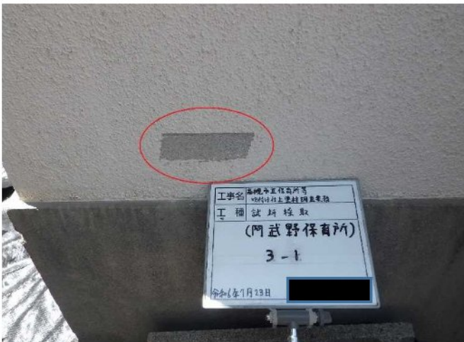
試料No.3 (採取後) 外壁 仕上塗材③
