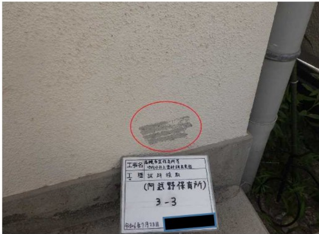
試料No.3 (採取後) 外壁 仕上塗材③
