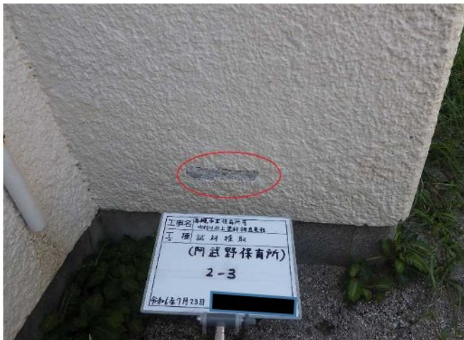
試料No.2 (採取後) 外壁 仕上塗材②
