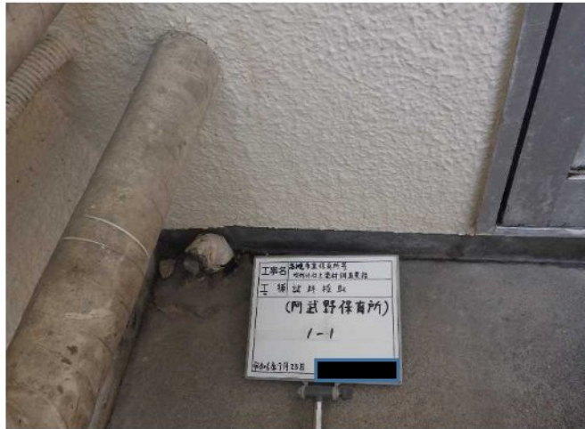
試料No.1 (採取前) 外壁 仕上塗材①
