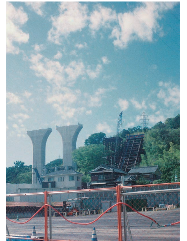
新名神高速道路の橋脚 (令和6年10月撮影) 高速道路の橋脚が、ハの字に青空に向かって伸びていて、体操の 伸びをしているように見えました。橋脚が息を吐いたような雲の配 置で撮りました。(ikarimame)
