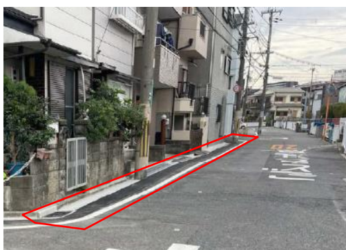
街渠改修（津之江北町）
