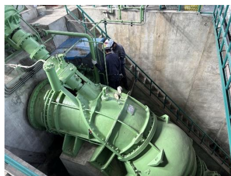
点検状況（玉子排水機場）
