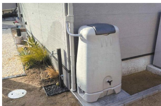
雨水タンクの設置
