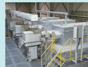
電気集じん機。焼却後の排ガス中のちりやほこりなどを、静電気を発生させて取り除く
