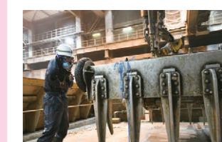
ピット内での整備
