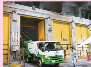
投入ステージ。扉は自動的に閉鎖し、臭いがもれるのを防ぐ
