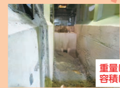
灰ピット。焼却炉からの灰を一時的に保管
