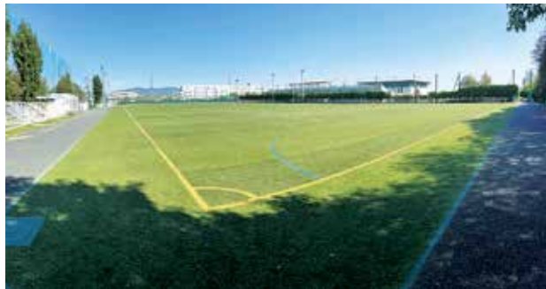
▲人工芝全面張り替え工事を実施する青少年運動広場
