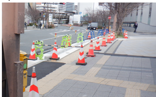
(写真) JR高槻駅西口北側の地下道出入口
