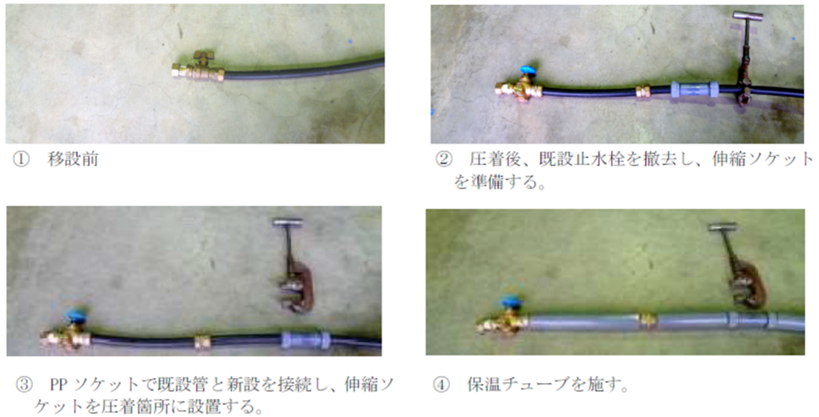
図-4.2.4.1 止水栓取替え手順
