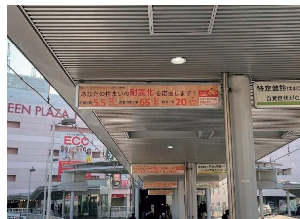
写真：JR高槻駅南 人工デッキ上情報提供施設による啓発
