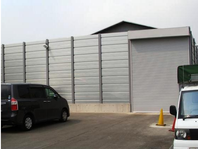
(防音壁の設置により、騒音を9.0デシベル低減する効果を確認)
