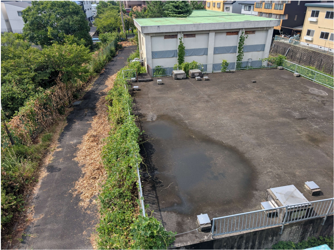
現況写真（全景）
