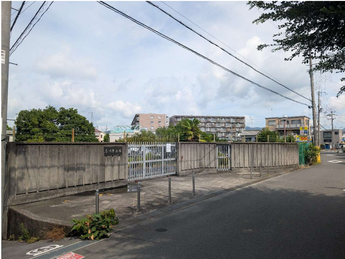
現況写真（全景）
