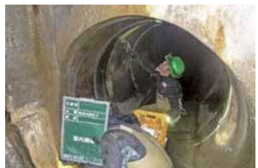
▲ 下水道管路の調査の様子
