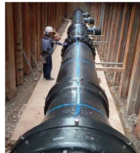
水道管更新工事の様子
