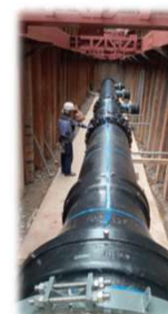
管路更新工事の様子
