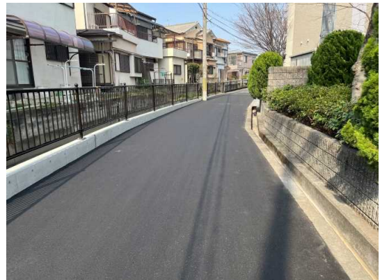
水路側壁のかさ上げ
