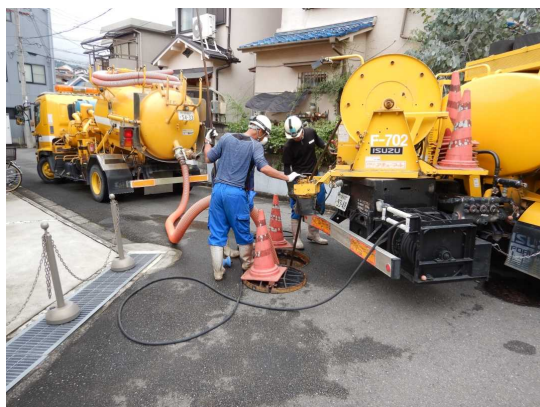
緊急浚渫による下水道の閉塞解消
