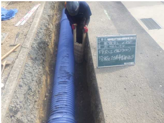
雨水管の布設
