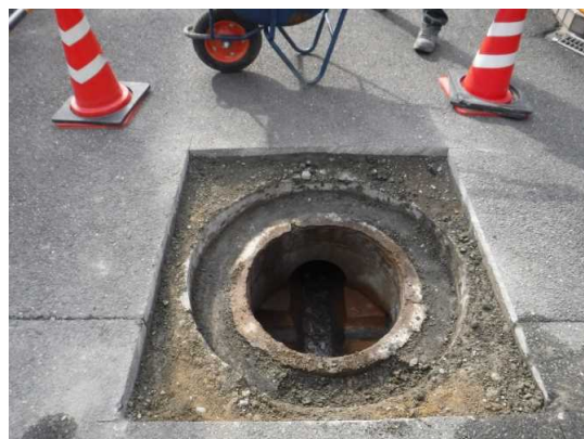
マンホール蓋の更新
