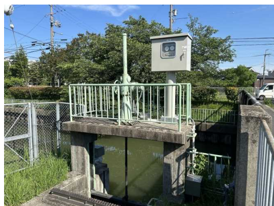
電気設備の更新
