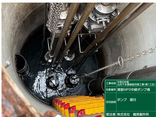
マンホールポンプの更新
