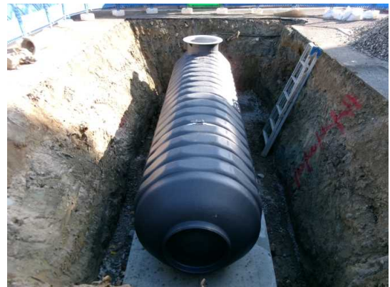
マンホールトイレ（地下貯水槽）の施工
