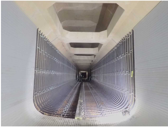
管更生工事の施工
