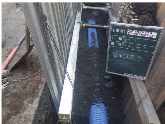
管きょの更新（布設替え）
