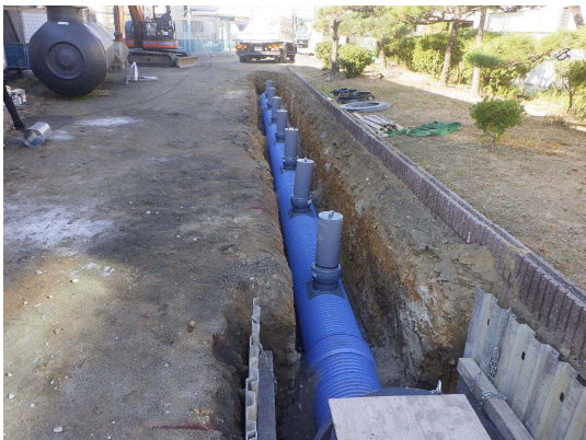
マンホールトイレ（貯留管）の施工
