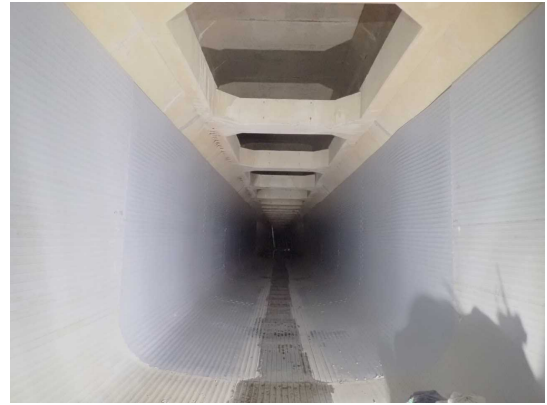
管更生工事の完成
