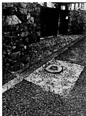
日吉台3番町1番付近 ●街路樹の撤去
