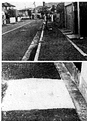
日吉台3番町 ●歩道の通行の妨げなどになる樹木の撤去
