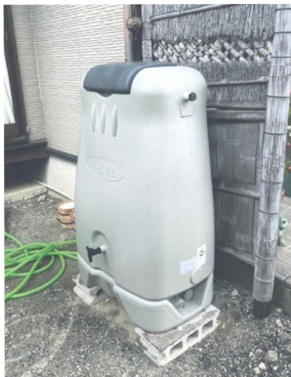
雨水タンクの設置
