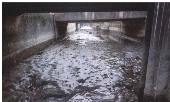
野田水路（施工前）
