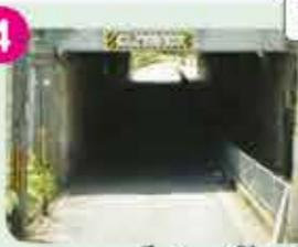
トンネルの出入り口が坂になってしまい、雨が降ればトンネル内に水がたまる。雨量が多ければ道路が冠水し歩行できない状態になる。
