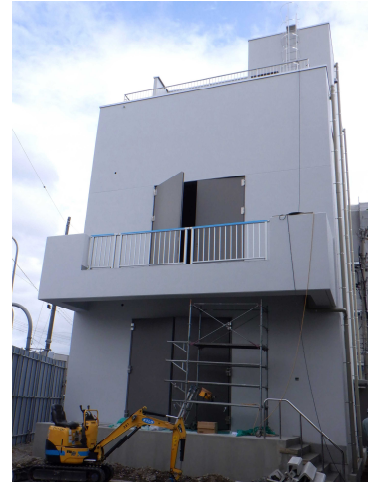
（写真）大冠浄水場非常用発電機棟
