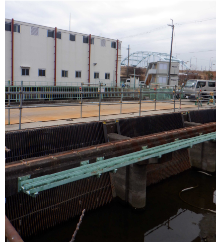
(写真) 走行式除塵機の撤去後
