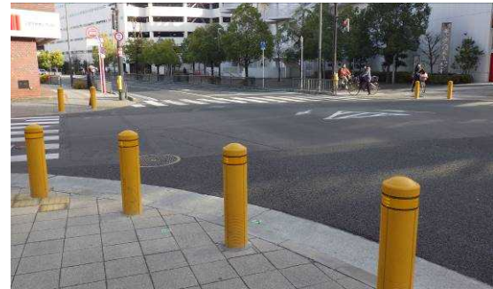
■交差点付近へのポール設置による安全対策
