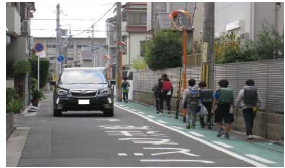
■整備後のグリーンベルト
