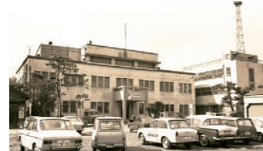
S40代.建て替え前の市役所庁舎
