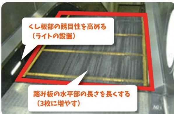
乗降口の手前にあるくし板部付近にライトを設置することで、くし板へのつまずきによる転倒リスクを低減する。
