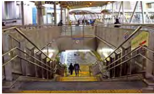
▲下りエスカレーター設置を検討中のJR高槻駅北側の階段
