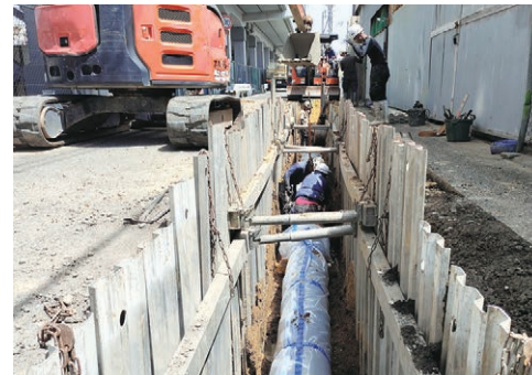
管路の更新工事
