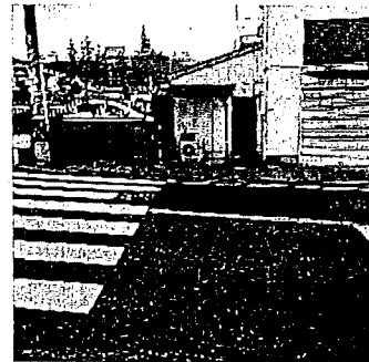
安岡寺町1丁目 ●道路整備:振動対策
