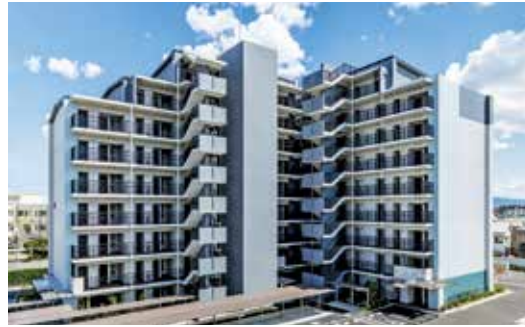
▲令和5年度に完成した富寿栄住宅の第1工区の住宅棟
