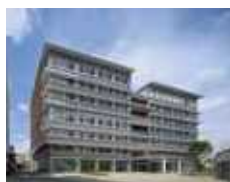
① (株)西島製作所
