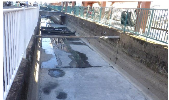
野田水路（施行後）
