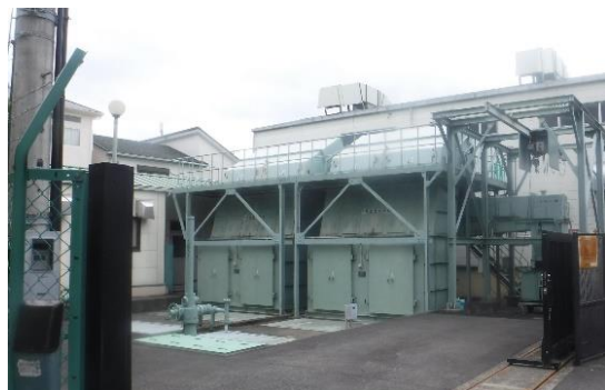
新川雨水ポンプ場（施行前）
