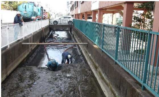
野田水路（作業状況）
