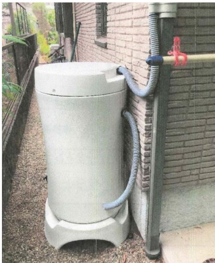
雨水タンクの設置
