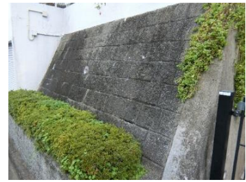
塀や擁壁に破損や落書きがないか
