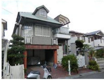
屋根、壁などの破損、劣化がないか
