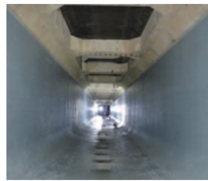
耐震工事後の下水道管の内部
