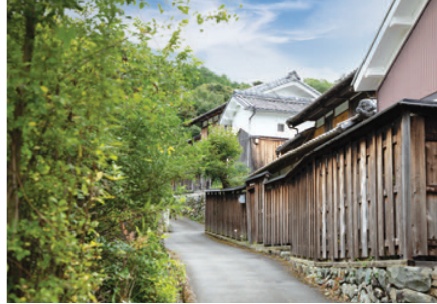
蔵がある家も多い。屋根は断熱に優れた「置屋根」なのだから
