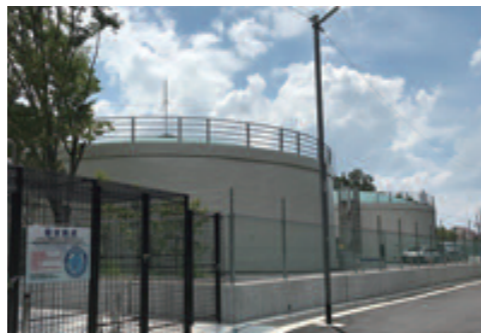
城山第1配水池
