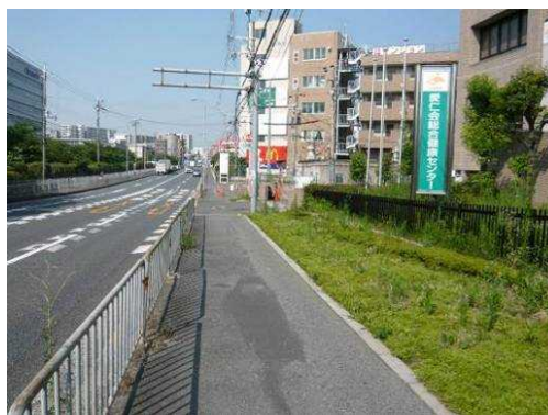
3 国道171号の現況
