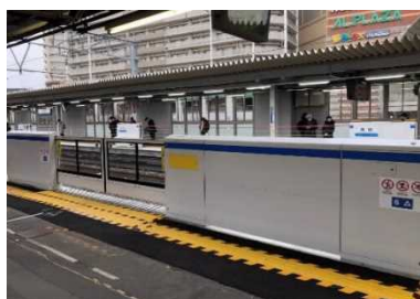
ホーム柵の設置
