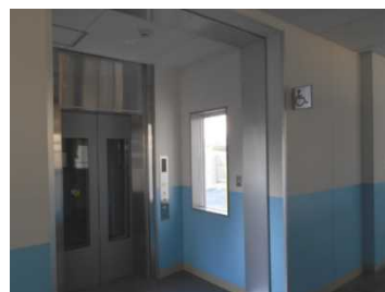
エレベーターの設置
