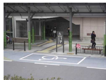
障がい者用駐停車帯の設置
