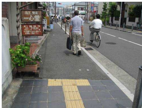
17 大手八幡線の現況
