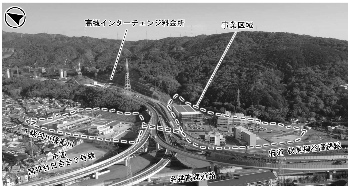
事業区域 全景（令和5年11月撮影）
