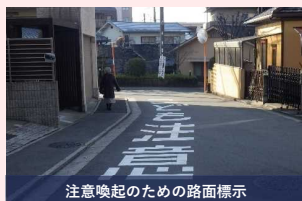
注意喚起のための路面標示
