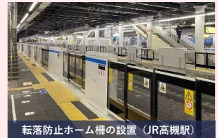
転落防止ホーム柵の設置（JR高槻駅）
