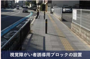
視覚障がい者誘導用ブロックの設置
