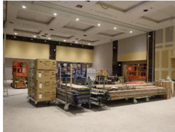
コンベンションルーム内装工事
