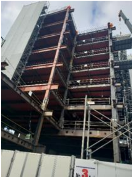
鉄骨組立工事
