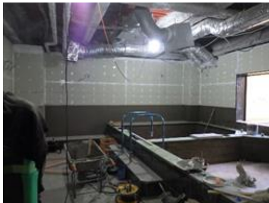
浴室内装工事
