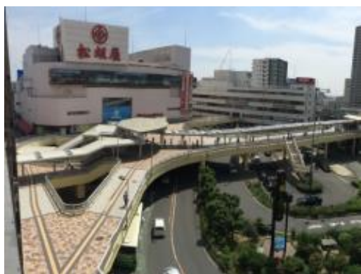
【JR高槻駅南人エデッキバリアフリー化 ・高質空間施設】
