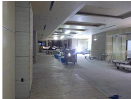
エントランス内装工事
