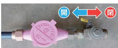
【レバー式】写真の状態が開 右に倒して閉
