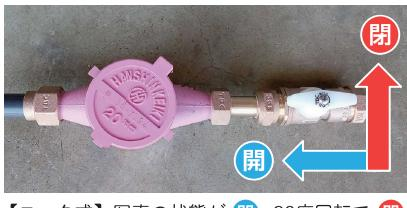
【コック式】写真の状態が開 90度回転で閉
