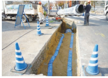
水道管路耐震化工事
