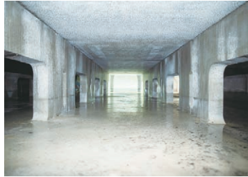
JR高槻駅北の雨水貯留施設
