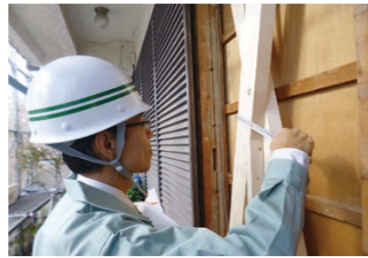
工事後耐震改修設計のとおり施工されているか市職員が確認
